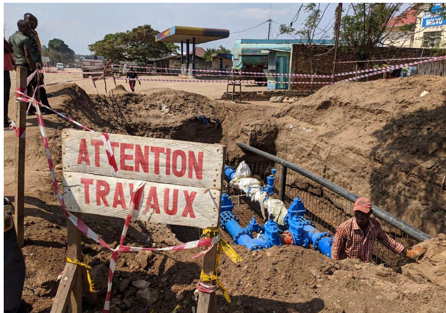
Les travaux menés conduisent à doubler la capacité de la station de traitement, de doubler la capacité de stockage de l'eau potable ainsi qu'à poser ou réhabiliter des conduites, des bornes-fontaines ou encore des branchements individuels
